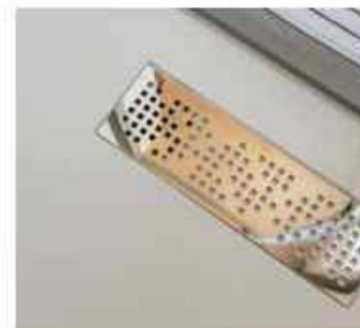
Pré-équipement du système de récupération des eaux grises Récupérateur des calories de l'eau de la douche
